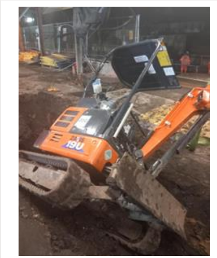
Final position of mini digger
